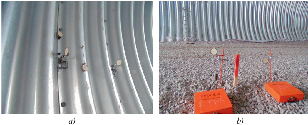
Рисунок 7 — Розміщення вимірювальних приладів на металевій гофрованій конструкції: а) прогиномірів П-1, П-2 та ПТГ I-1 та I-2; б) прогиномірів П-5, П-6
